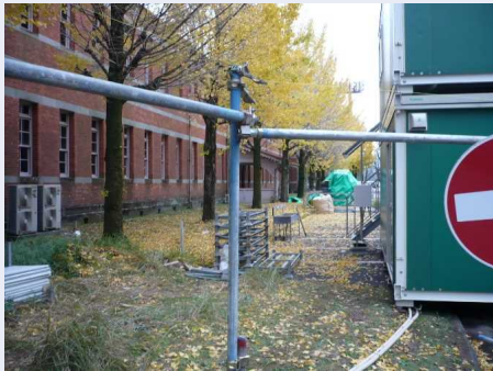
五高裏・防壁設置 (2017/11/24)
