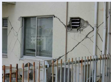
外来臨床研究棟の壁
