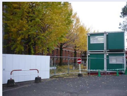
五高裏・防壁設置 (2017/11/24)
