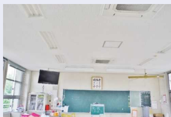
復旧後の教室の天井
