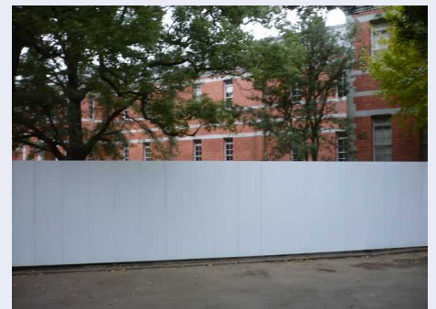
五高横・防壁設置 (2017/11/24)
