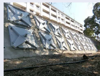
復旧後の擁壁
