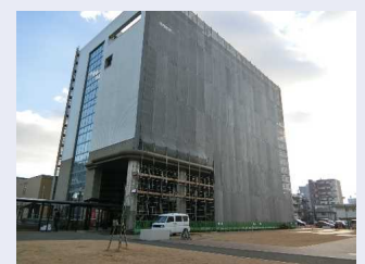
復旧作業の足場で囲われた建物
