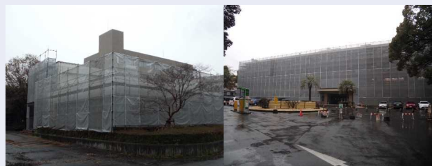
復旧作業の足場で囲われた建物
