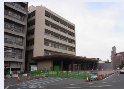
管理棟を取り壊し後に、取り壊しを開始 する外来臨床研究棟、立入禁止措置中
