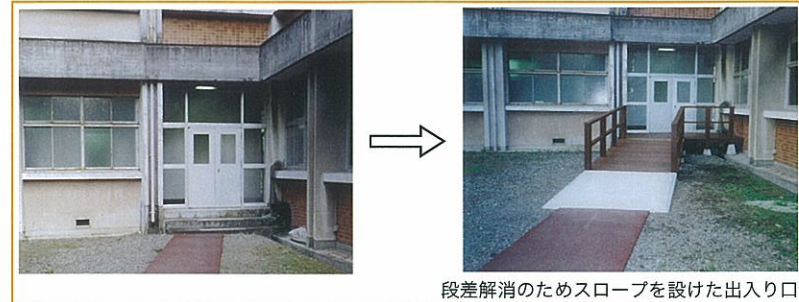
段差解消のためスロープを設けた出入口口
