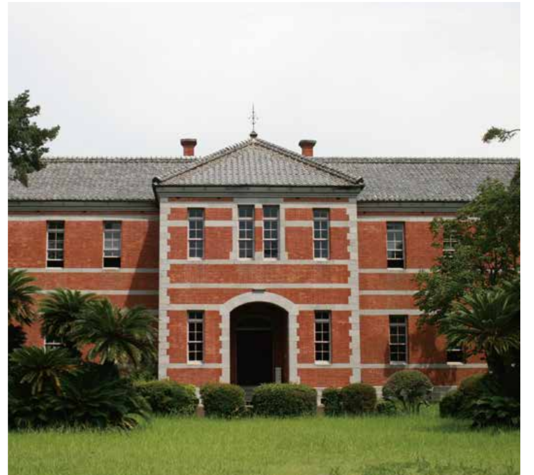
熊本地震の被害により、現在は修復工事中の五高記念館
