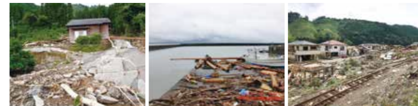
芦北町の土石流により破壊された道路
