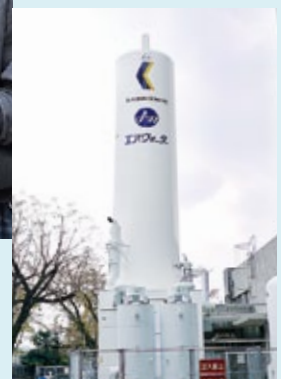
→ 念願のヘリウムと窒素の液化機が導入され、黒髪南キャンパスの同センター横に巨大なタワーが登場した
