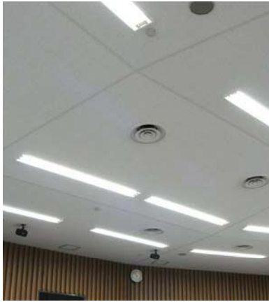
照明を自動調整し電力の供給バランスを最適化(工学部2号館)
