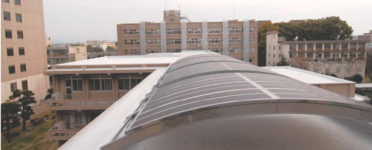
工学部2号館屋上に設置されたソーラーアーチ
