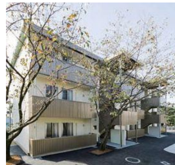
学生の増加に対応して11月に「国際交流会館」が新たに3棟オープン。既設の宿舍と合わせて全232室になり、部屋数が倍増した。研究に集中できる環境もさらに充実している
