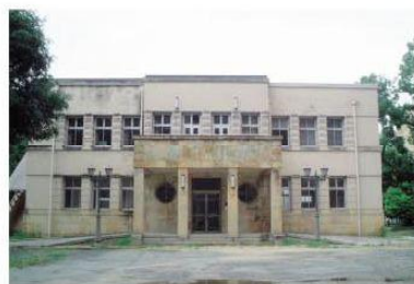
熊本大学医学部附属病院の敷地にある山崎記念館。昭和6(1931)年、山崎博士の長年の功績を記念して建設された。今年はじめ、世界最先端の医療設備を整えた新中央診療棟を建設するため、建物をそのまま移動させる「曳き家」工法によって48m移動し、90度回転したうえ、保存。今後一般に公開される。
