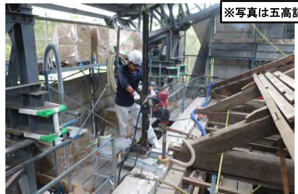
引張材挿入補強 ※煉瓦壁の鉛直方向の補強 (壁頂部よりコア削孔し、ステンレス製の引張補強材を挿入)
