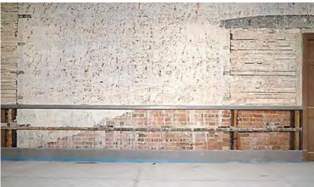
①復原教室南壁に残る階段の墨付け跡と漆喰下地
