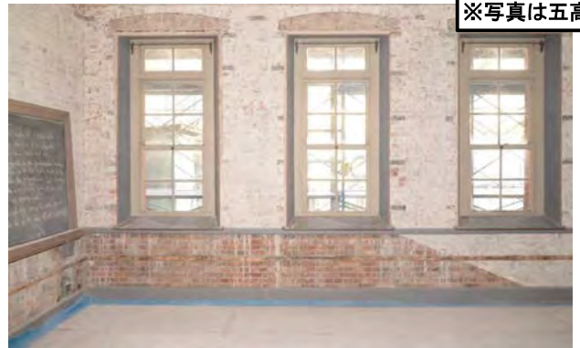
②復原教室北壁に残る階段の墨付け跡と漆喰下地
