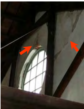
内壁ひび割れ・剥落・ずれ
