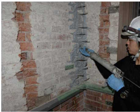
ひび割れ部にセメント系の材料 (グラウト材)を充填
