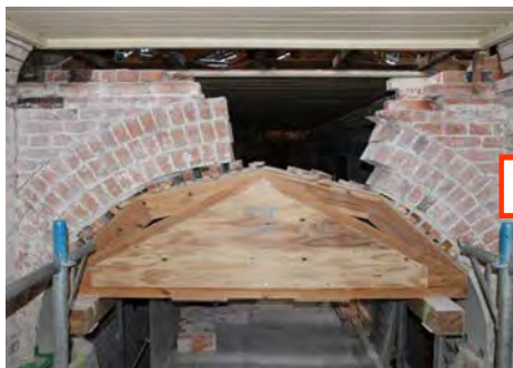
落下の恐れのある部分を解体
