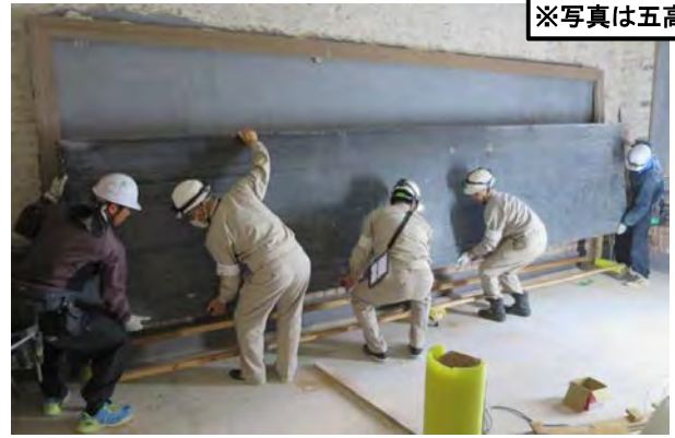
各教室の既存黒板解体
