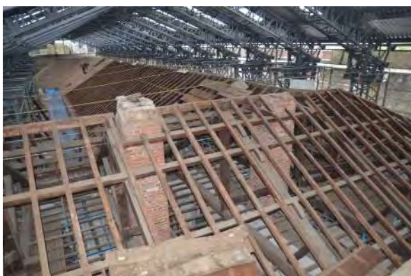
屋根野地板解体
