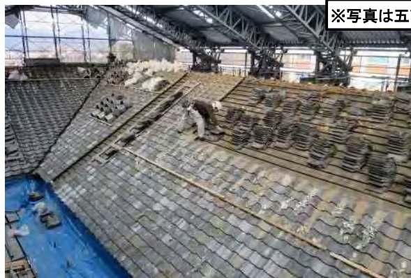
屋根棧瓦葺解体（瓦約26,000枚 全体の約5割が再利用可）
