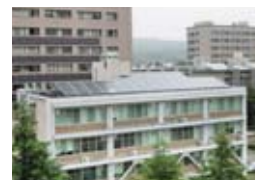
共用棟黒髪2 26kW
