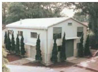
昔の 中央廃液処理施設 (1977年設置)
