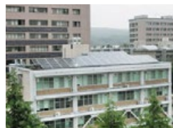
共用棟黒髪2 26kW
