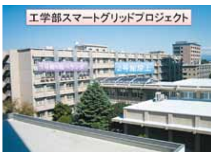
1号館5階ベランダ、2号館屋上
