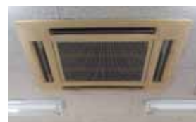
空調機取替前
