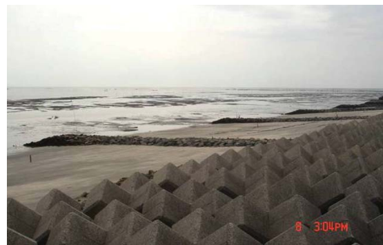
防災と環境の調和した海岸堤防
