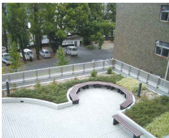
発生医学研究センターの屋上緑化
