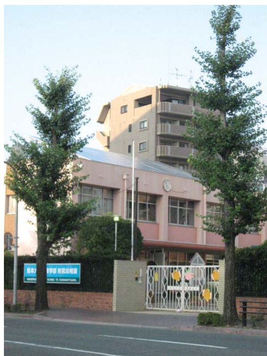
附属幼稚園に設置されているソーラーパネル
