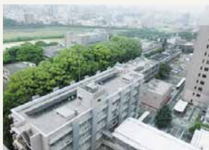
研究実験棟屋上 50kW
