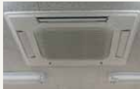
空調機取替後
