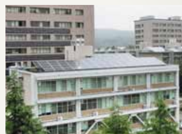
共用棟黒髪2 26kW
