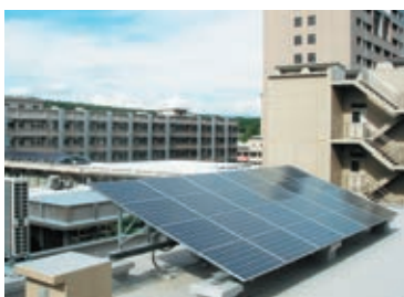
工学部研究棟Ⅳ
