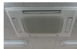
空調機取替後
